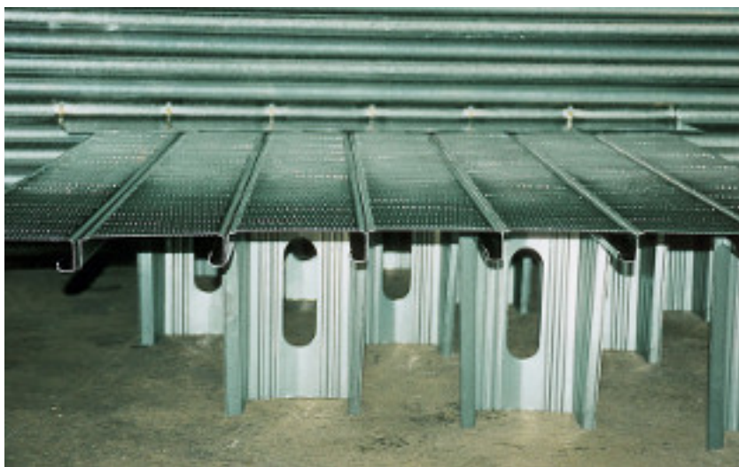
Фигура 18.3: Под на клетка с напълно перфорирано дъно. Вижда се захващането на отделните елементи един към друг и стойките за монтаж.
